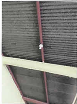
Foto 3: SUSTITUCION DE ILUMINACION Y FUERZA EN CORREDOR, DIRECCION, AULA 1 Y 2
