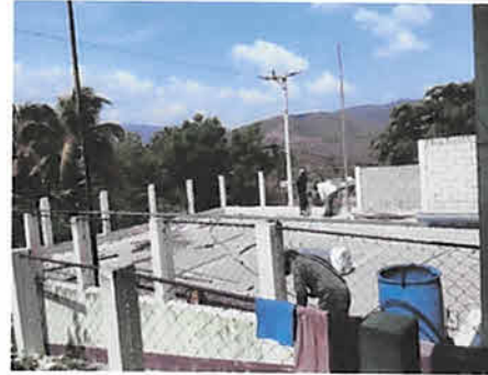
Foto 2: Cambio de malla en muro perimetral y area de patio 1 y 2
