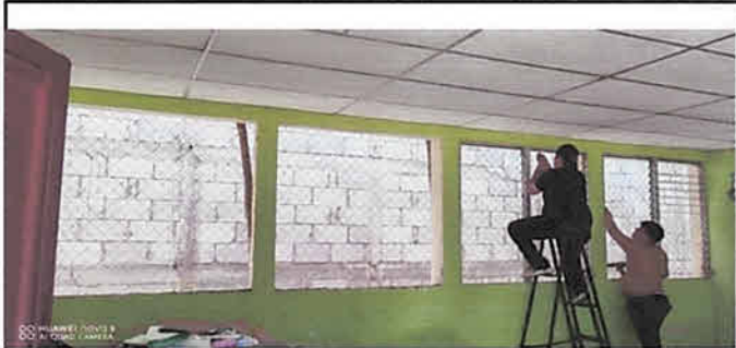
Foto8: Instalación de ventanas pvc
