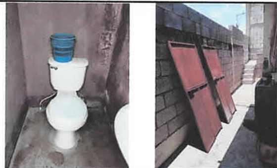
Foto 7 Y 8: Mantenimiento a estructura (lijado, cambio de tubo , cepillado, sujeciones, aplicacion de pintura) a puertas servicios sanitarios y sustitucion de inodoro
