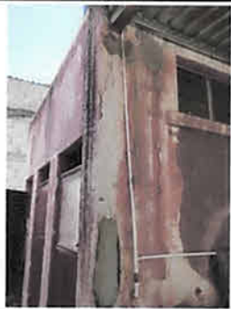
Foto 6: Sustitucion de accesorios deposito de agua
