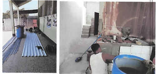
Foto 4 Y5: AREA DE PILA TECHO Y AZULEJO PARA PILA
